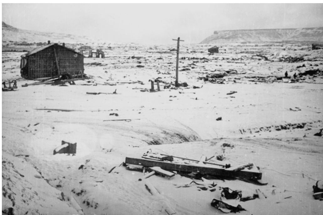
Рис. 1. Вид центральной части г. Северо-Курильск, уничтоженного цунами 1952 г. Фото Л. Бондаренко
