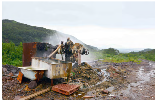
Рис. 6. Состояние гидротермальной скважины П-2 в 2014 г.
