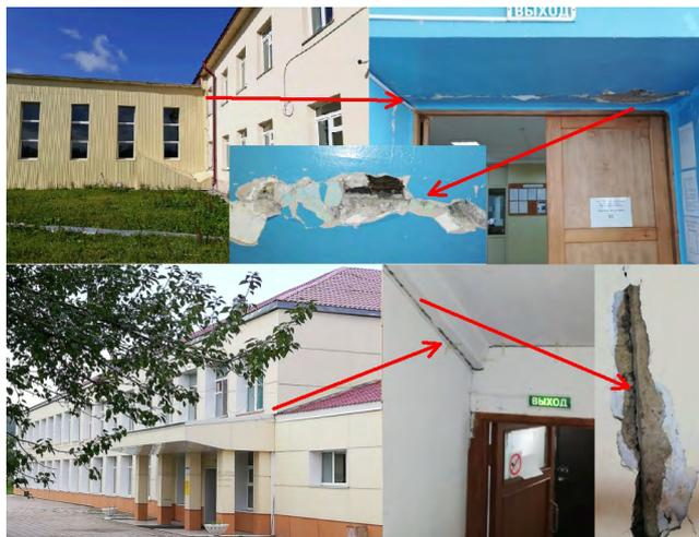
**Рис. 2.** Выявленные повреждения зданий школ в селах Никольское (вверху) и Краснополье (внизу) по результатам макросейсмического обследования эпицентральной зоны Углегорского землетрясения 13.09.2020. Фото Д.В. Костылева
